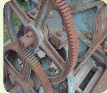
El hierro en contacto con el oxígeno se convierte en herrumbre
