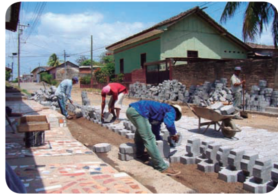
Adoquinamiento de las calles en un barrio
