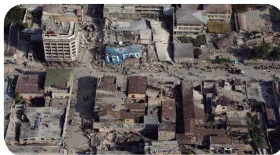
Construcciones colapsadas en Puerto Príncipe (terremoto del 12/01/2010 en Haití)
