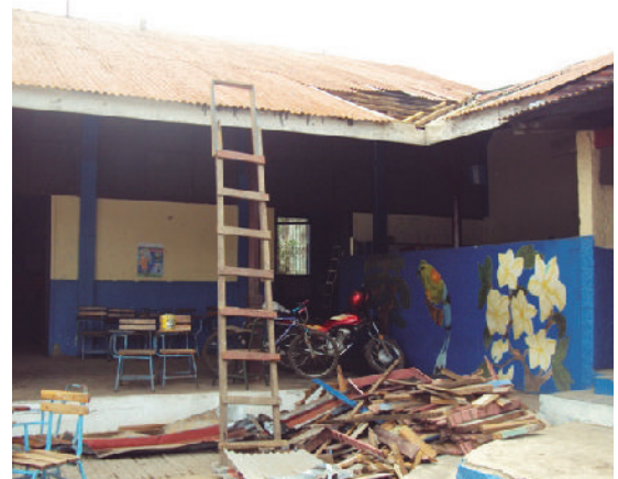
Reparación de escuelas
