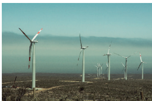
Generación de energía eólica
