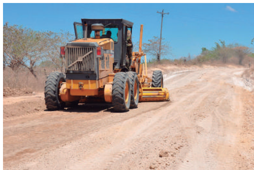
Reparación de caminos
