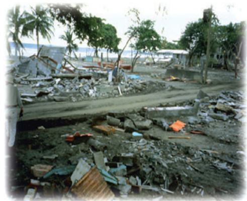
Desastre del Tsunami
